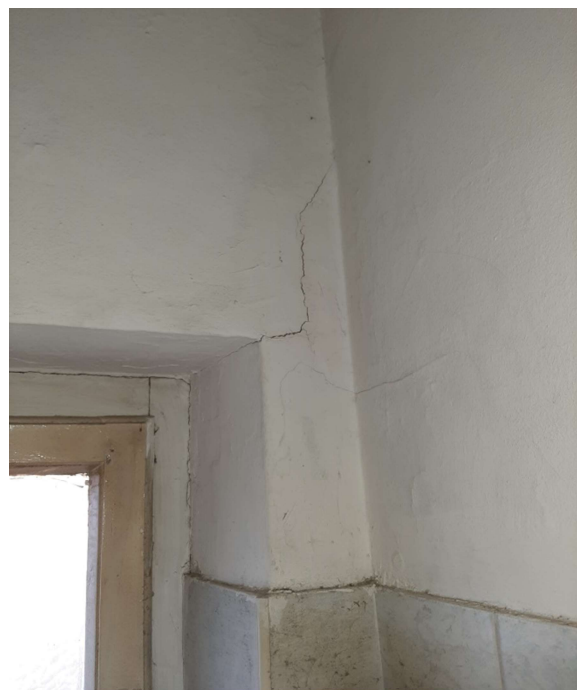
Foto A crepa nel muro del bagno
